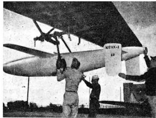
Bomba volante americana KUSN1, montada bajo el ala de un avión para ser soltada en vuelo.
