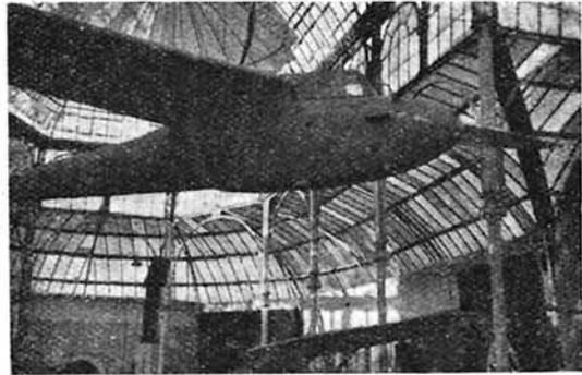
*Velero "Weihe", de 18 metros de envergadura y coeficiente de planeo muy próximo al 1/30. Apréciase el "venturi" del horizonte artificial y el perfil recto de la cabina de plexiglás.*
