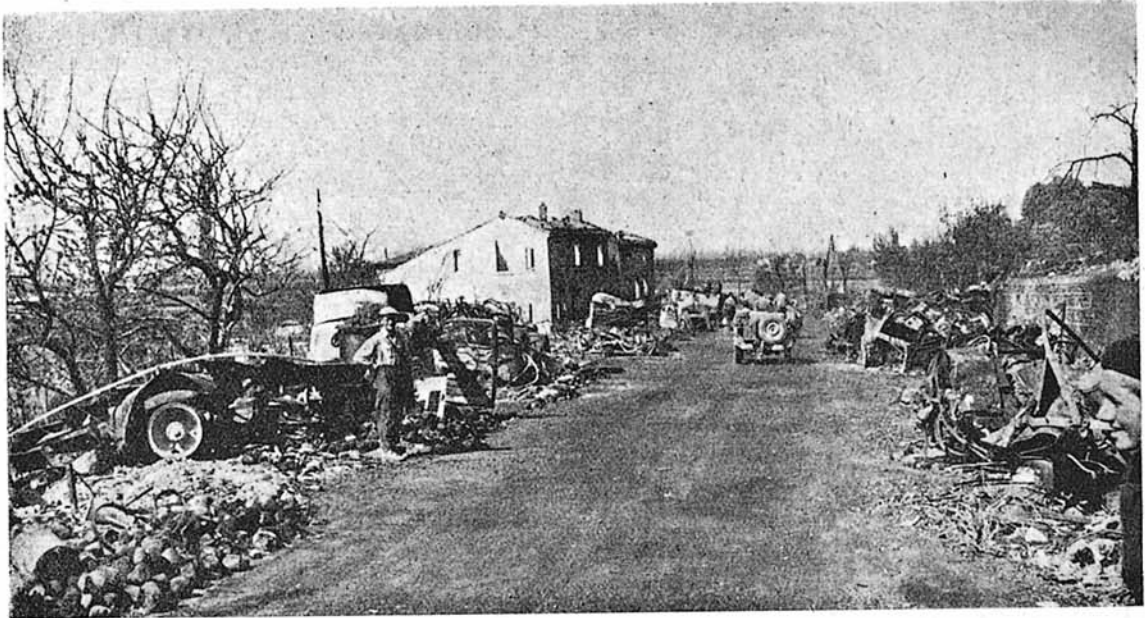
Aspecto de una carretera de la Riviera después de ser limpiada de obstáculos. La vía, una vez desembarazada de los restos de vehículos destruidos, es puesta nuevamente en servicio.
