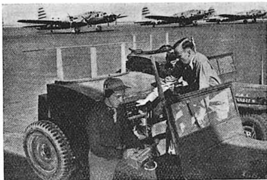
Dos "jeeps" con los instrumentos utilizados para hacer aterrizar y despegar a distancia.
