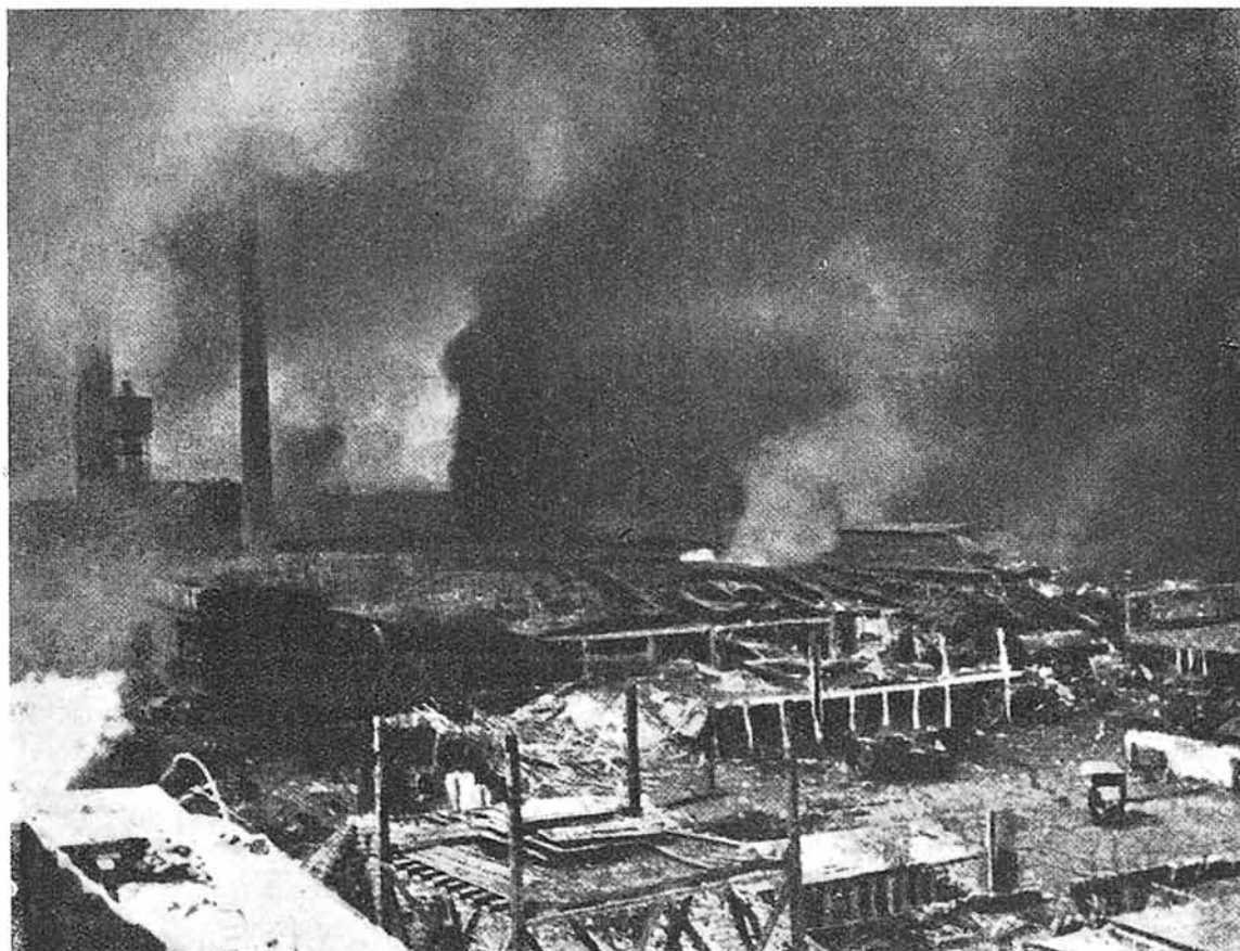
Bombardeo por la 8. a Fuerza Aérea americana de la fábrica de aviones Fieseler, donde se construían gran número de cazas "FW-190".
