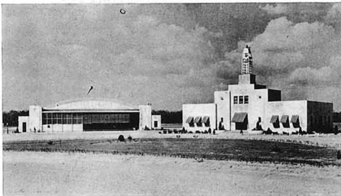
Vista diurna del aeropuerto de Baton Rouge.
