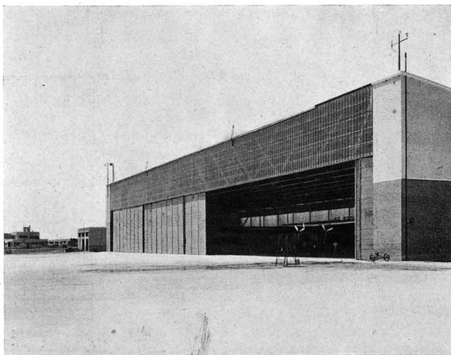
Fig. 8. — Vista de un hangar con las luces rojas de obstrucción, montadas en su techo.
