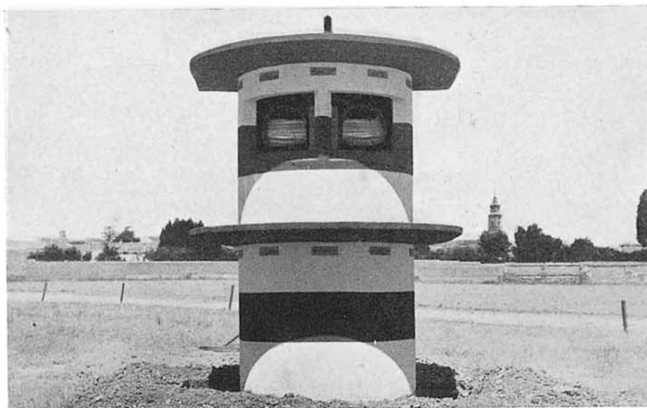
Fig. 12. — Vista diurna del proyector gemelo, de 20 kilovatios, instalado en su caseta en el Aeropuerto.
