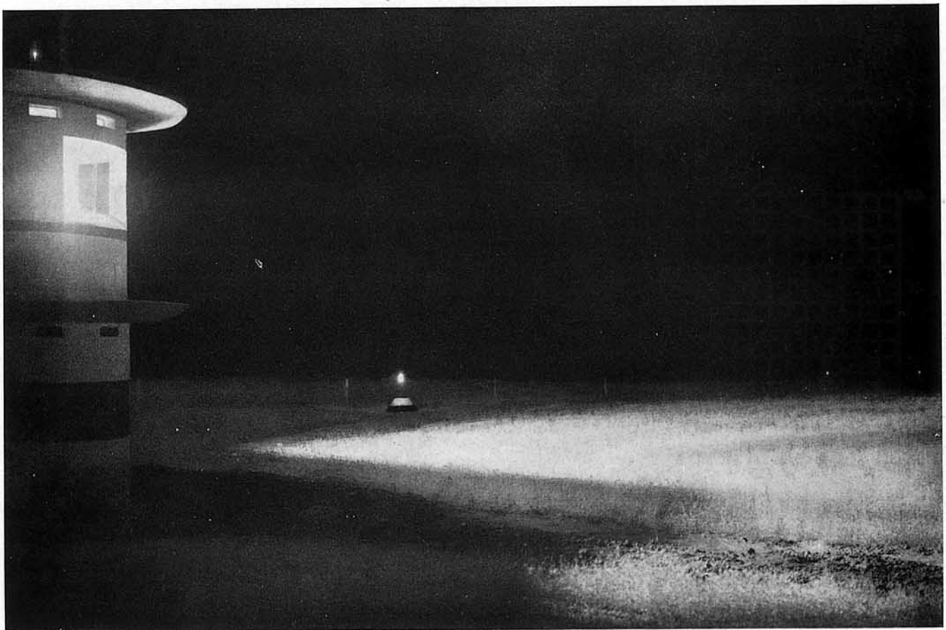
Fig. 11. — Vista nocturna del proyector gemelo de 20 kilowatios instalado en el Aeropuerto.
