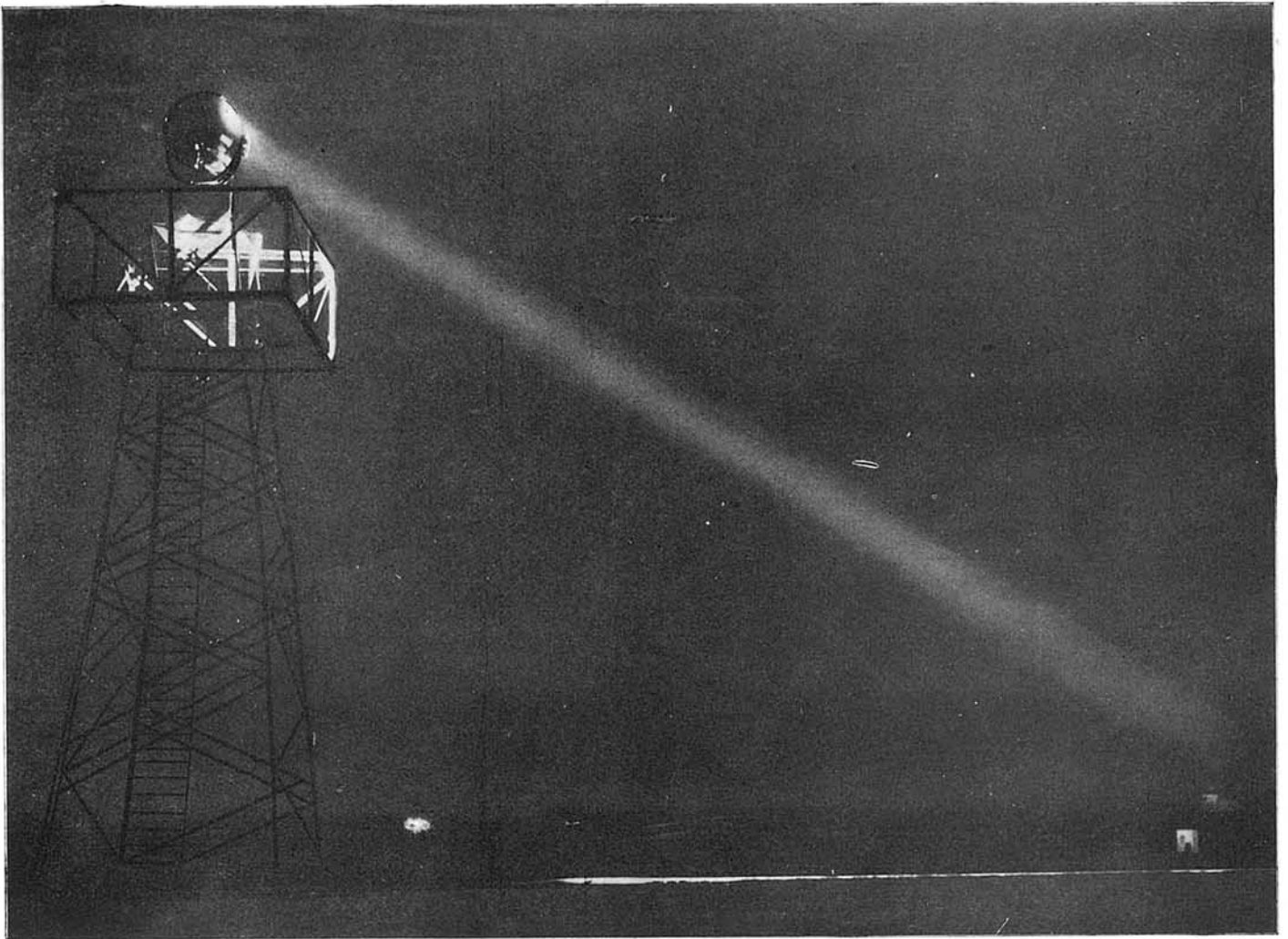
Fig. 4. — Vista nocturna del faro de posición.
