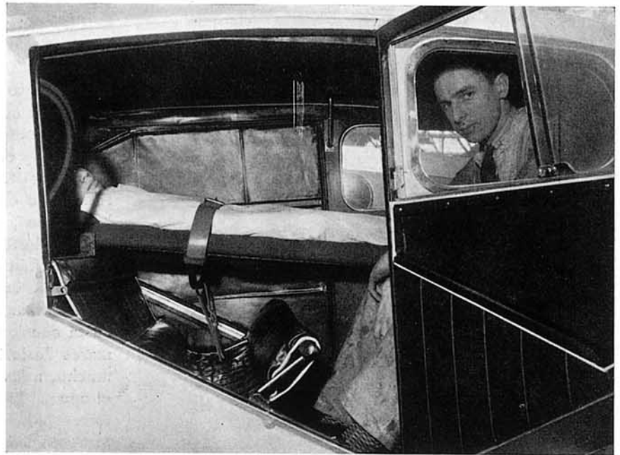
Avión D. H. 83 «Fox Moth» convertido en sanitario. Presenta algunas diferencias con el modelo standard; especialmente el acceso a la cabina ha sido ampliado para la entrada del enfermo en camilla.
