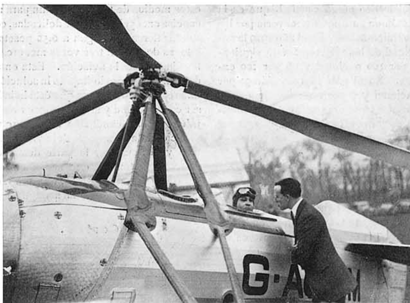
El ingeniero Sr. La Cierva a bordo del nuevo modelo de autogiro de palas plegables. En la parte anterior de la pirámide se ve la transmisión y mecanismo de embrague para la puesta en régimen de vuelo del rotor, con el fin de acortar el despegue.
