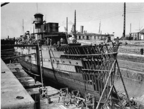
Figura 2. Construcción del forro y armazón de un barco
