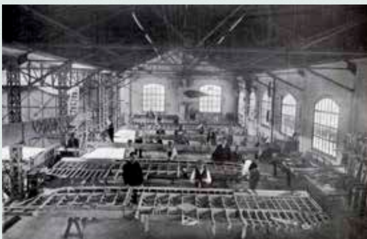
Fabricación de la estructura de las alas del Loring R.III.
