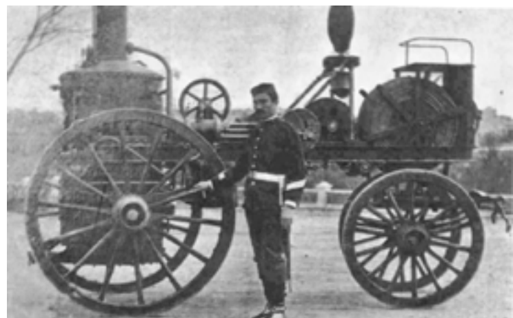
Tren Yon. Vagón de polea y máquina de vapor productor de fuerza para descender los globos cautivos.
