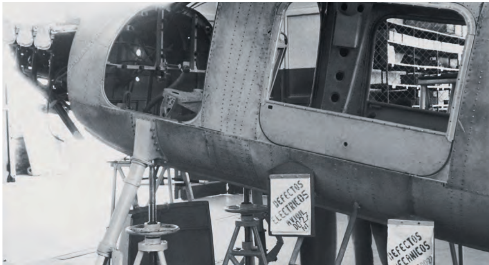
La C-127 número 1 en proceso de montaje. Nótese los registros de defectos eléctricos y defectos mecánicos en primer plano, donde en ambos se había escrito "avión Do-27 n° 1".
