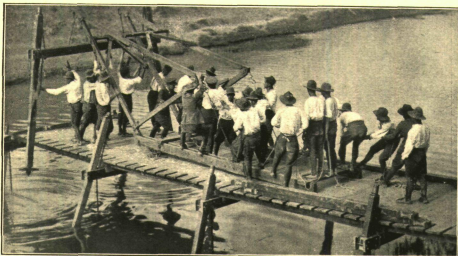
Tendido del puente de vanguardia
