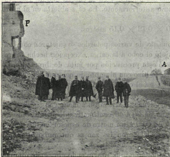
DESPUÉS DE LA EXPLOSIÓN
