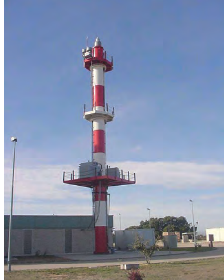
Figura 4.1-9. Torre de Medidas del CEAR (Fuente Ministerio de Defensa).
