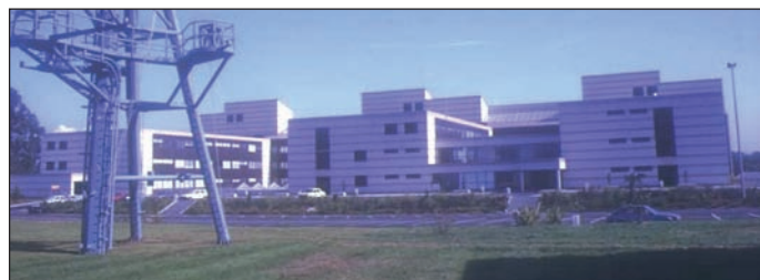
Figura 5. Hospital de Marina de Ferrol.
