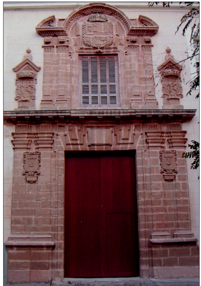
Figura 1. Portada del Hospital Real de Marina de Cádiz
