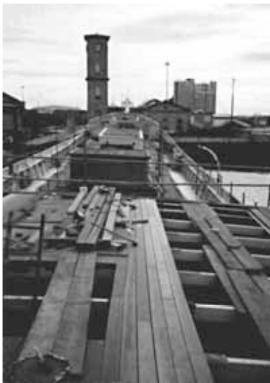
Restauración de la cubierta.
