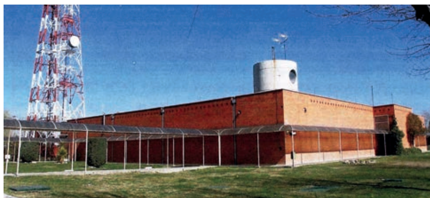
Búnker. Finalizada su construcción en 1976, este edificio acogió al nuevo Centro de Operaciones de Combate (COC) y Centro de Operaciones del Sector (SOC). Estaba situado junto a las antiguas instalaciones de la Red de Alerta y Control existentes en la base aérea de Torrejón, construidas en 1958
