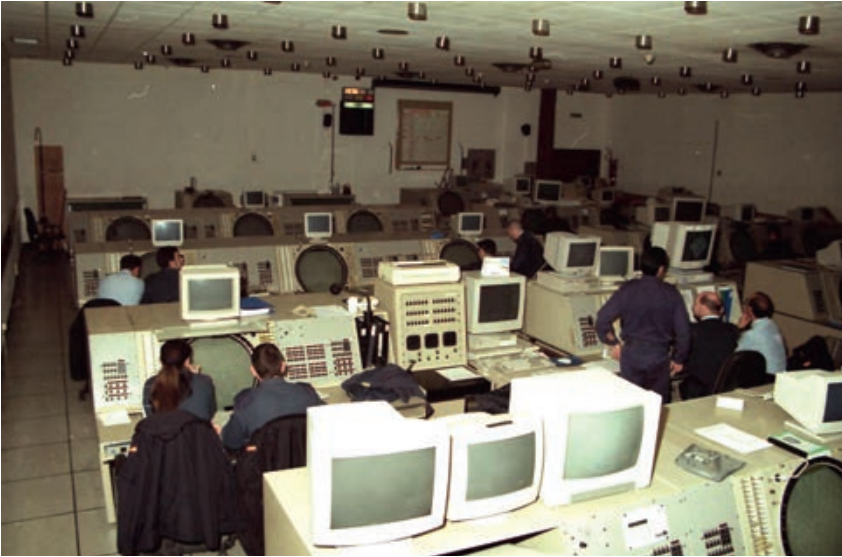
Sala del Centro de Operaciones del Sector (SOC). Sistema SADA. Estaba situada junto al Centro de Operaciones de Combate (COC) en el búnker
