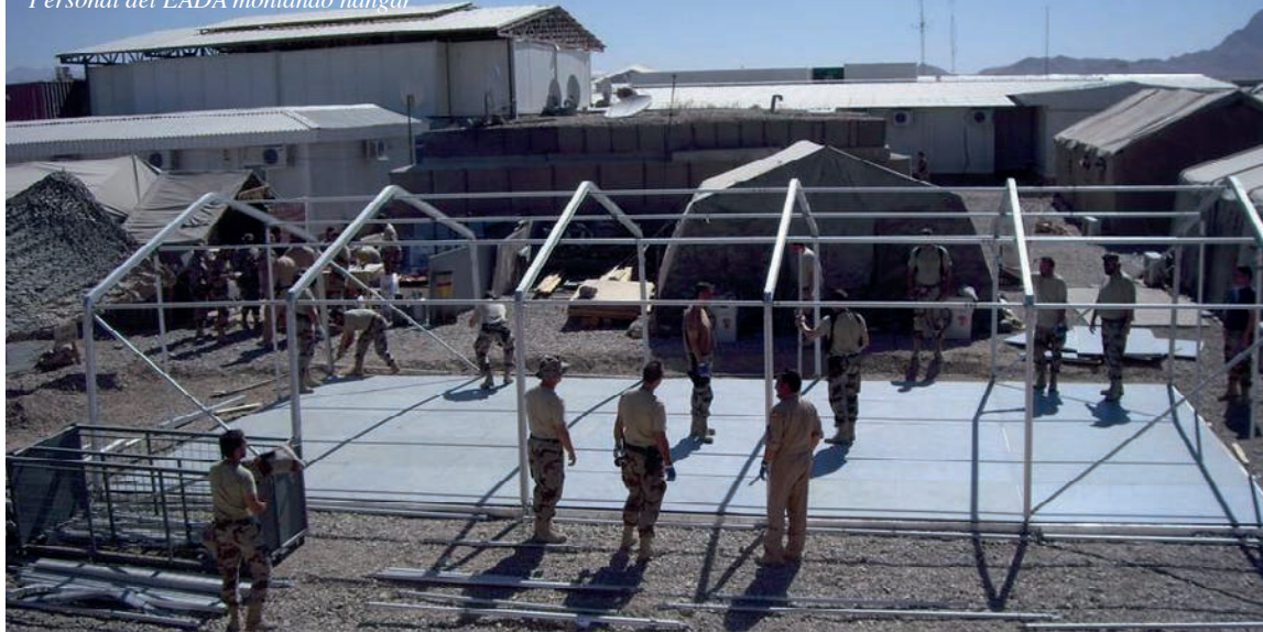
Personal del EADA montando hangar
