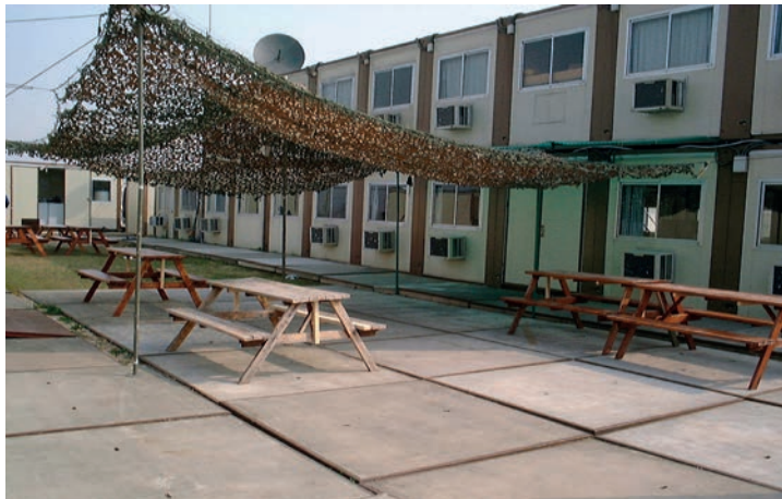
Instalación de módulos por parte de la Sección de Material de Despliegue del EADA en la base aérea de Aviano
