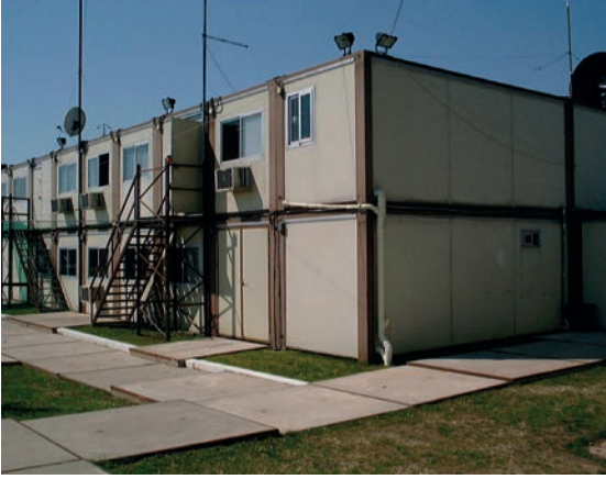
Instalación de módulos por parte de la Sección de Material de Despliegue del EADA en la base aérea de Aviano
