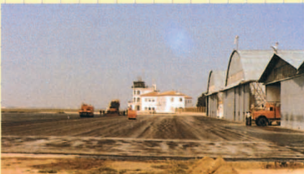
Asfaltado de la plataforma de aviones.
