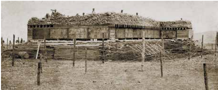
3.- Blocao protección tren minero
