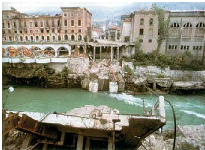
57.- Puente Viejo de Móstar destruido
