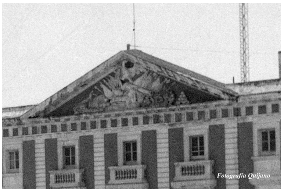
Fig. 9. Detalle de la fachada principal del edificio Luis de Córdoba. (Foto: Archivo Quijano)
