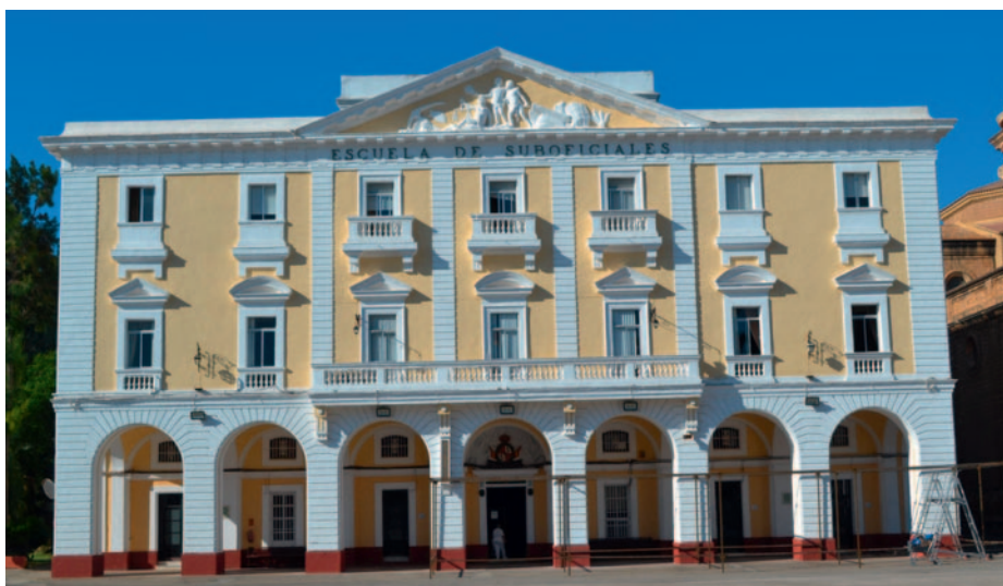
Fig. 16. Fachada principal del edificio Carlos III, hoy Escuela de Suboficiales. (Foto de la autora)
