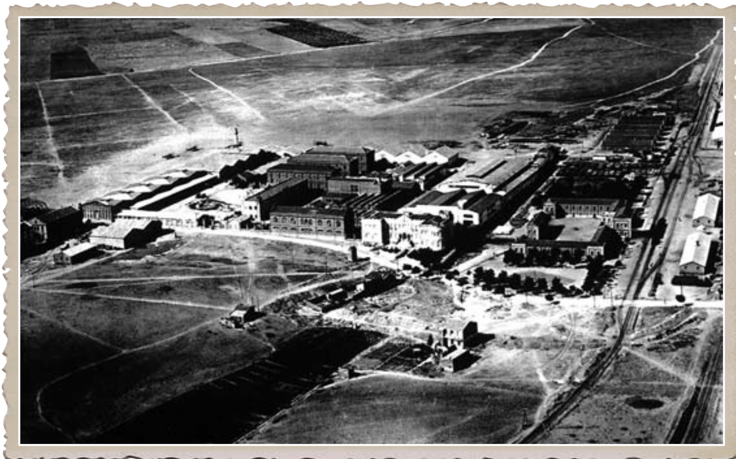
→ Vista aérea del aeródromo de Cuatro Vientos que permite apreciar su excelente y conveniente ubicación próxima a las vías férreas y la instalación de Ferrocarriles (de Ingenieros) (foto: Archivo Histórico del Ejército del Aire).
