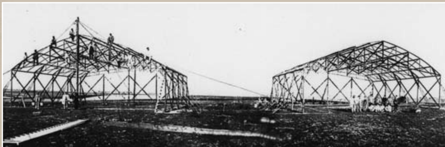
→ Tras los dos primeros hangares portátiles “Bessonneau”, los dos primeros de fábrica (en construcción) en Cuatro Vientos (foto: Archivo Histórico del Ejército del Aire).
