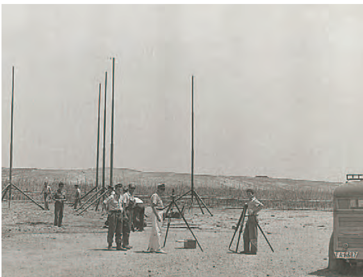
Lámina 5. Gonio Adcock siendo instalado en el aeropuerto de Las Palmas en el año 1952. Fuente: Archivo del autor.
