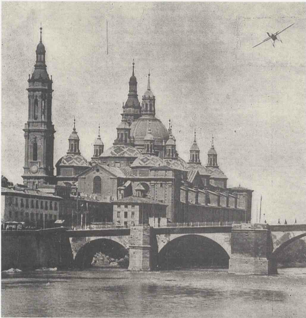
Lámina 4. "Magnífica fotografía de un aeroplano Bleriot pilotado por Gaget sobrevolando el Pilar de Zaragoza el 18 de abril de 1911".
