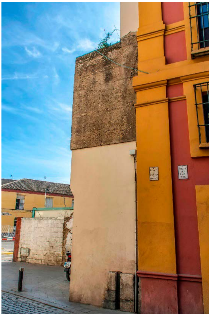
Restos del desaparecido postigo del Carbón, en la calle Santander. Fuente: Elaboración propia
