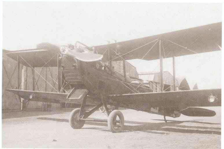
El Napier DH-9-66 estaba provisto de faros de iluminación nocturna.
