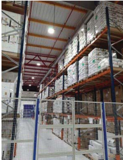
Zona de almacenes
