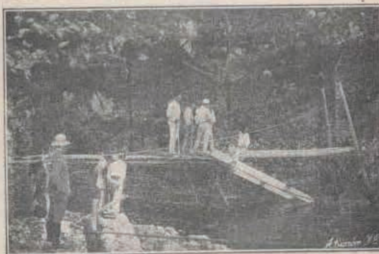
Fig. 19.—Tendido de un puente de cabaltes sobre el río Muga.
