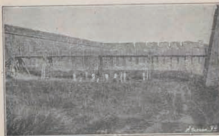
Fig. 4.—Puente de caballetes en el foso.
