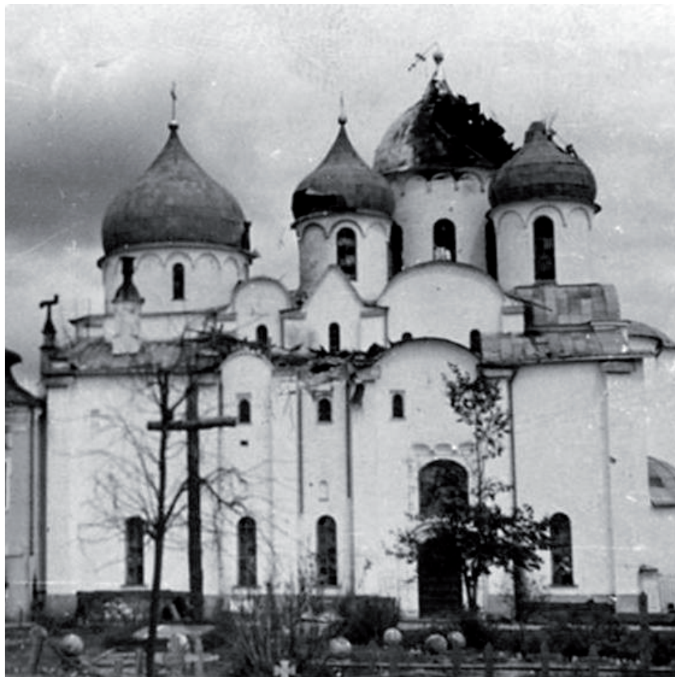
Estado de la cruz que remataba la cúpula central antes de ser bajada por los zapadores del 250.º Batallón
