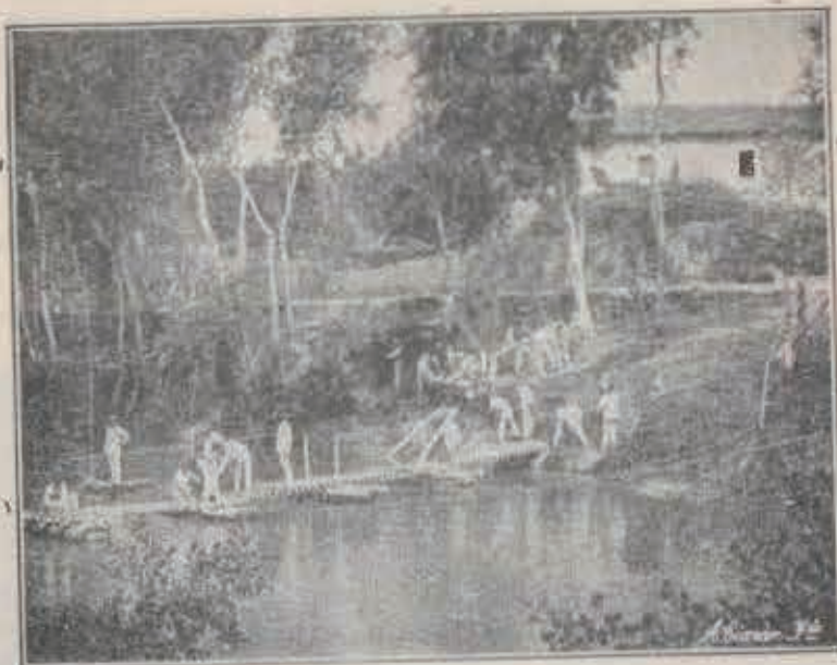
Fig. 15.—Puente de flotantes en el río Muga.
