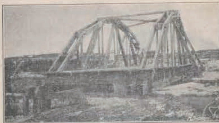
Fig. 3.—Puente de vigas poligonales (vista longitudinal).
