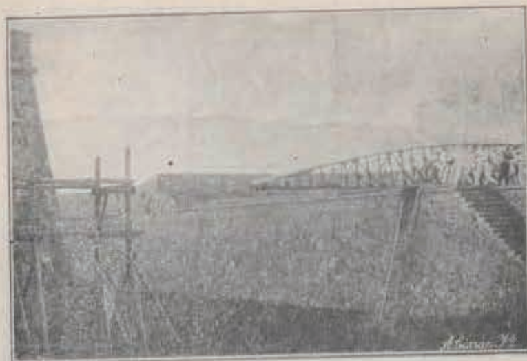
Fig. 8. — Pasadera de asalto. Avance de la pasadera.
